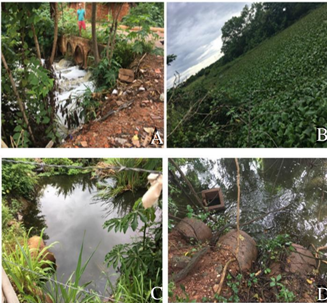
Figura 6 – Detalhes: (A) Rua Mariano Campos Maia, montante da lagoa natural; (B) Vista de montante para jusante da lagoa, percebe-se acúmulo de vegetação que dificulta o escoamento da água; (C) Rua Manoel Ribeiro da Silva, vista para dentro da lagoa evidenciando acúmulo de resíduos sólidos; (D) Vista dos bueiros tubulares na saída da lagoa, baixa vazão de saída.
