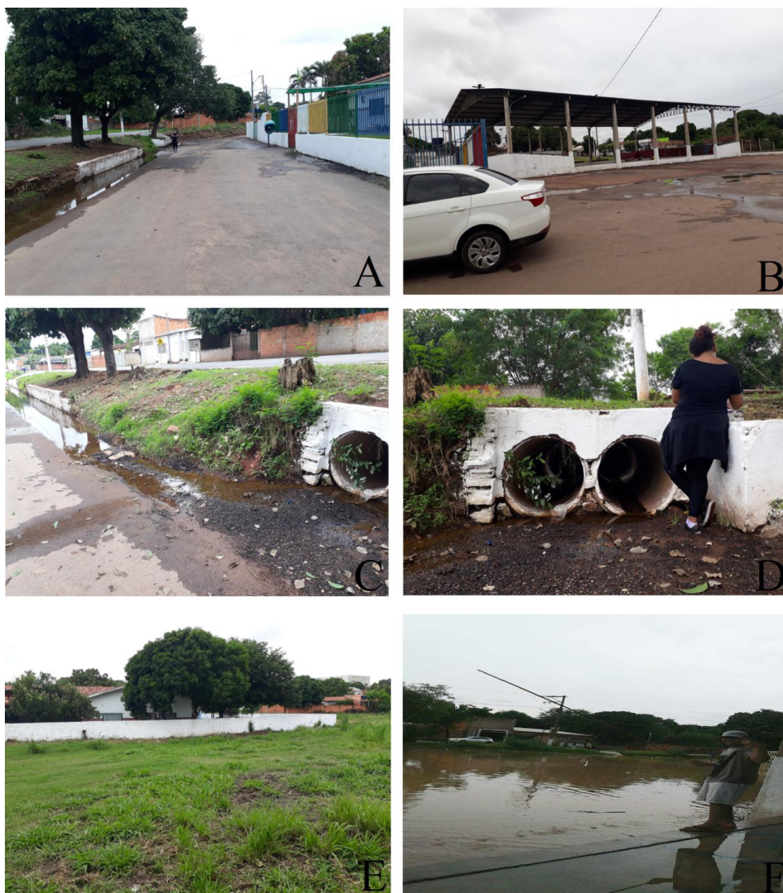
Figura 4 – Detalhes: (A) Rua paralela à Avenida Gonçalo Botelho de Campos evidenciando umidade no asfalto em frente à Creche Municipal; (B) Praça Cultural situada ao lado da Creche Municipal onde também se percebe a rua com muita umidade; (C) Elementos de microdrenagem (sarjeta e leito carroçável); (D) Elementos de microdrenagem (bueiros tubulares); (E) área úmida presente atrás da Creche Municipal; (F) inundação em evento chuvoso ocorrido em 12/03/2015, fonte: imagem cedida por moradores e de autoria própria.
