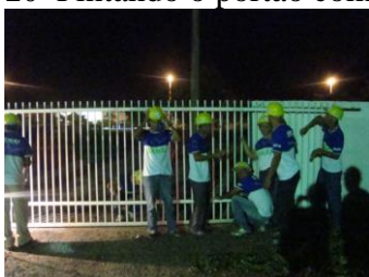
10 Pintando o portão com o uso de compressor
