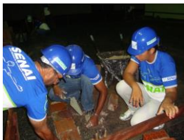
4 Construção do alicerce
