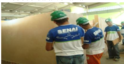
7 reboco da alvenaria
