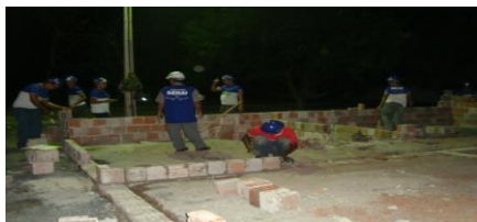
5 Construção do alicerce
