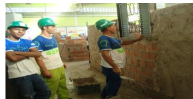
6 – preparação para reboco
