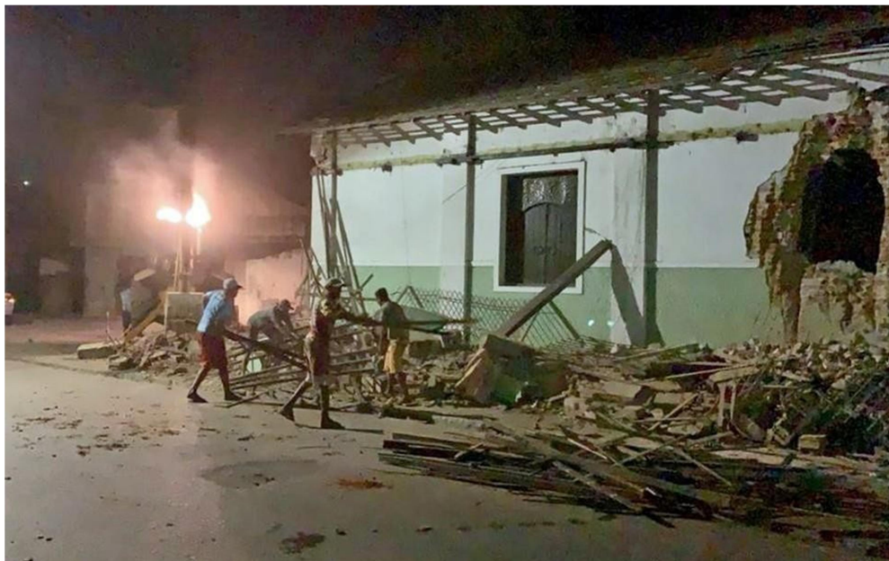
Figura 01. Imóvel demolido, em Bom Jardim-PE.
