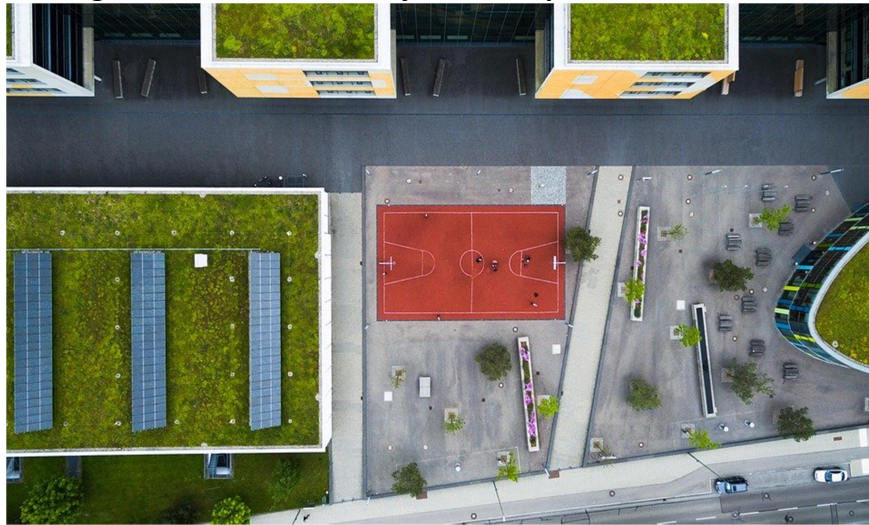
Figura 04. Telhado verde junto com placas fotovoltaicas.
