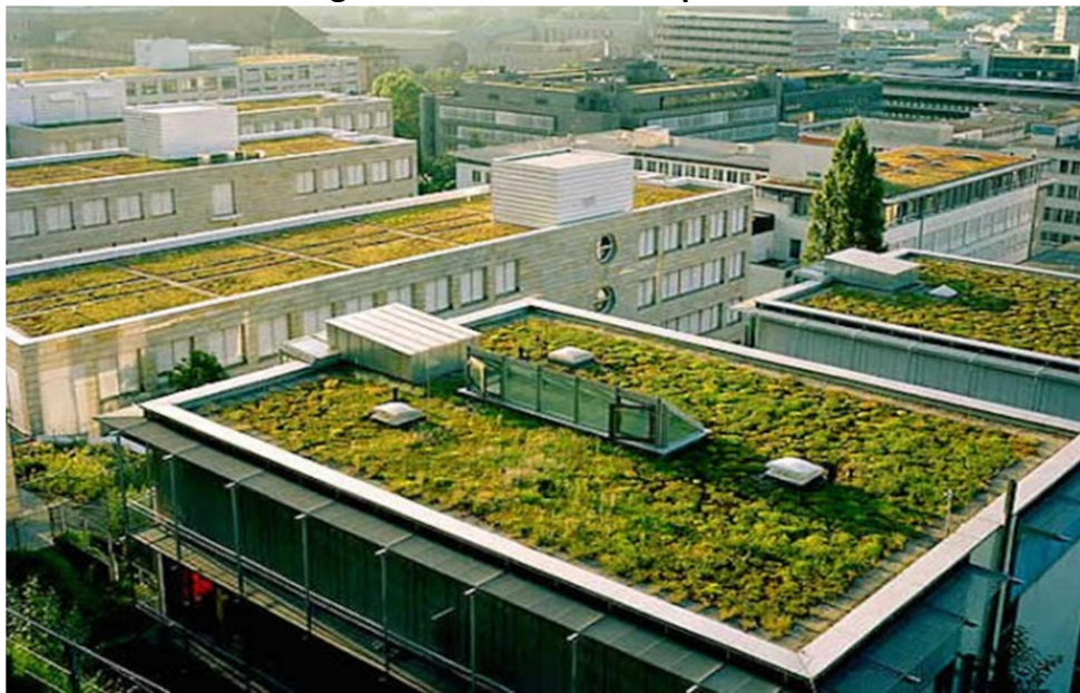
Figura 01. Teto verde em prédios
