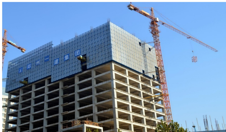
Figura 05: Edifício modular pré-moldado
