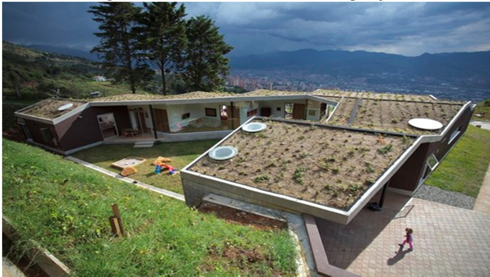
Figura 6. Base de telhado verde com vegetação
