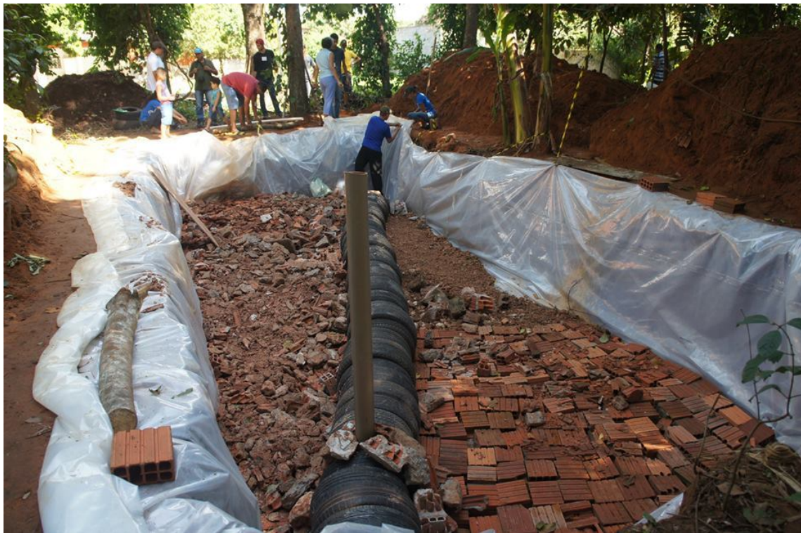
Figura 04 – Tanque de Evapotranspiração em implantação no Núcleo Breuzim.
