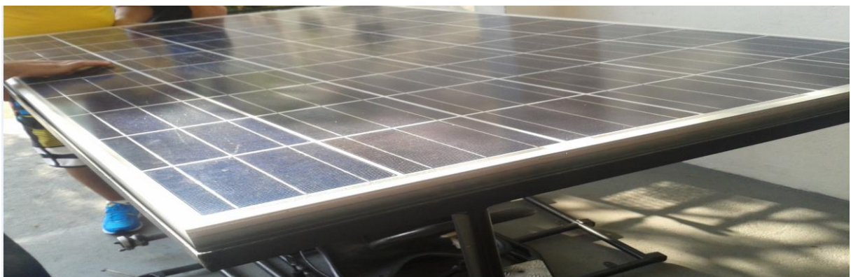
Figura 8 - Montagem do painel fotovoltaico.
