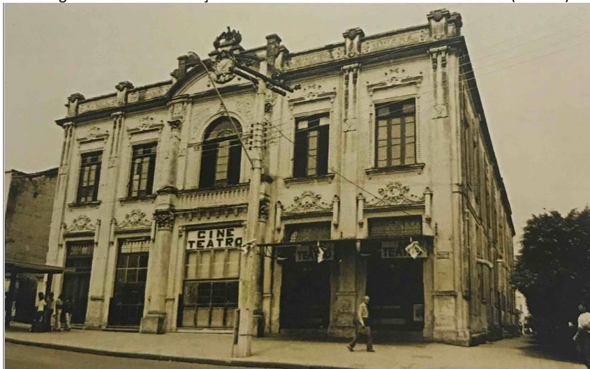
Fotografia 1 – A deterioração física do edifício do CineTeatro - fachada (c. 1980).
