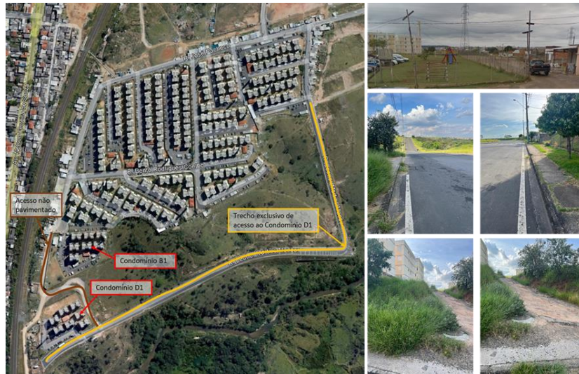
Figura 2 – Sirius: acesso ao Condomínio D1
