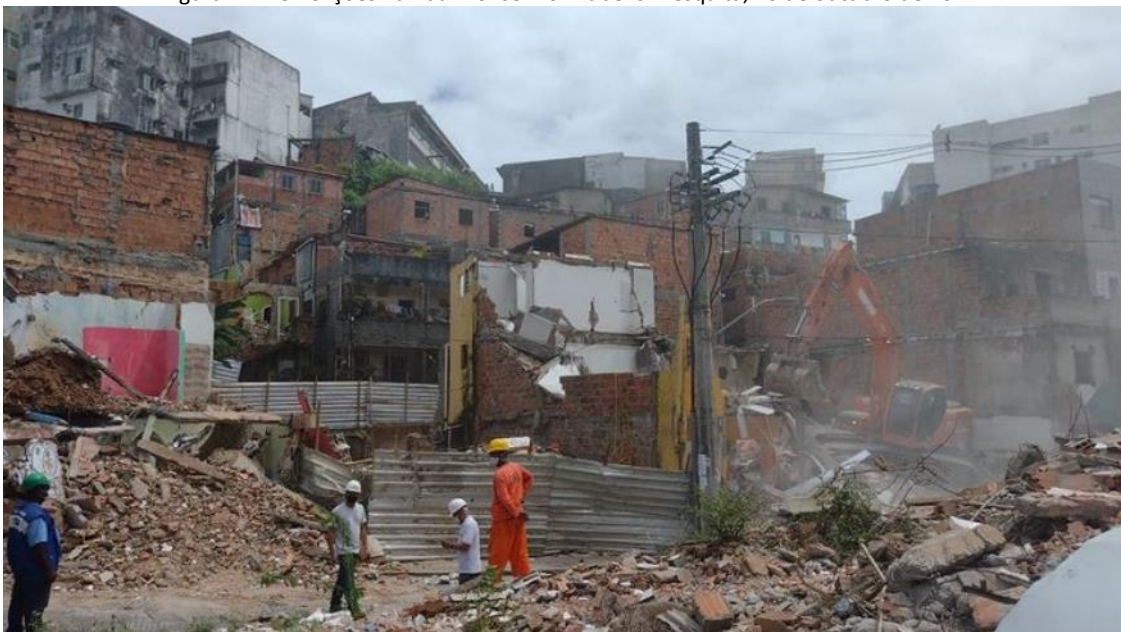
Figura 2 – Demolições na Rua Monsenhor Rubens Mesquita, 26 de outubro de 2021
