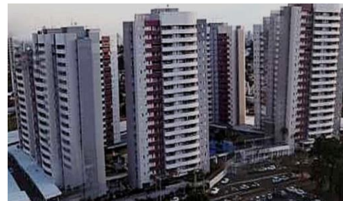
Figura 3 Condomínio Residencial recente
