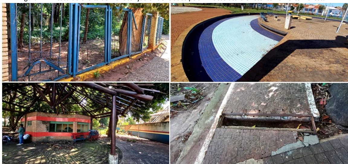
Figura 12 - Descuido e falta de manutenção evidenciados pela infraestrutura existente no Horto Florestal
