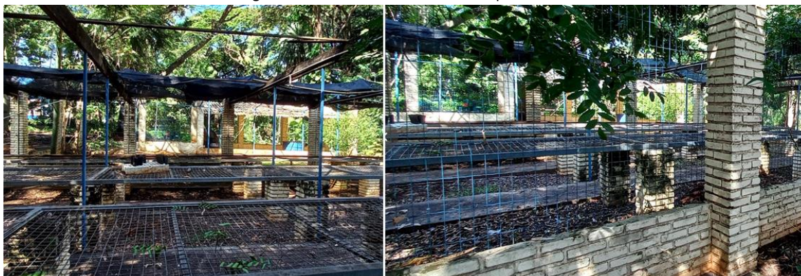
Figura 7 - Estruturas destinadas ao orquidário
