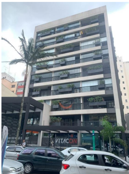
Figura 1 - Fachada do edifício com apartamento de 10 m 2 localizado no bairro da Santa Cecília.
