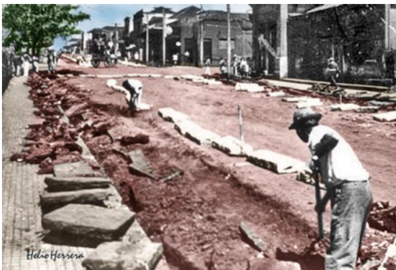
Figura 5 – Início do processo de instalação das sarjetas em Assis
