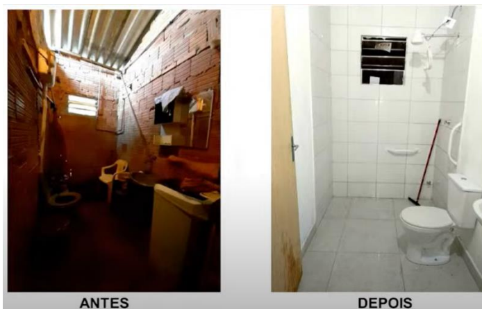
Figura 9 – Foto antes e depois de um banheiro que utilizou o serviço da assessoria técnica para reforma
