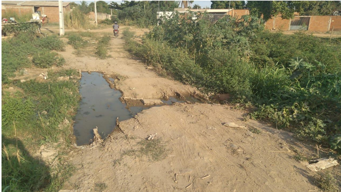
Figura 10: Esgoto sendo drenado até o rio.
