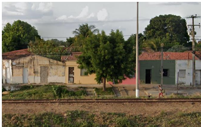
Figura 4 – Tipologias construtivas existentes no bairro Vila Neuma
