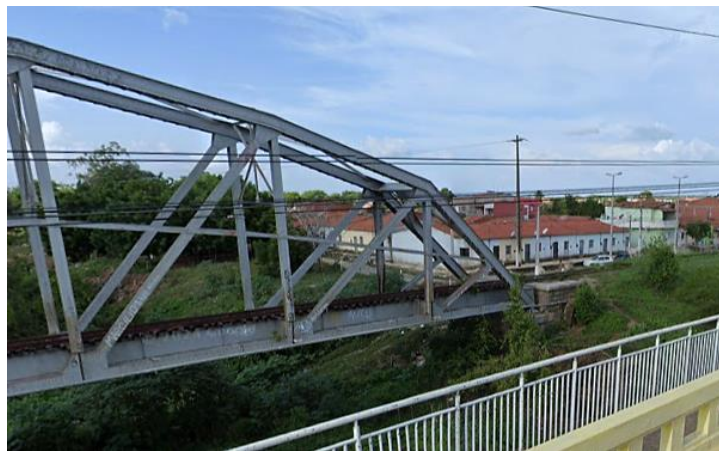
Figura 3 – Construções da Vila Neuma nas margens do rio Jaguaribe
