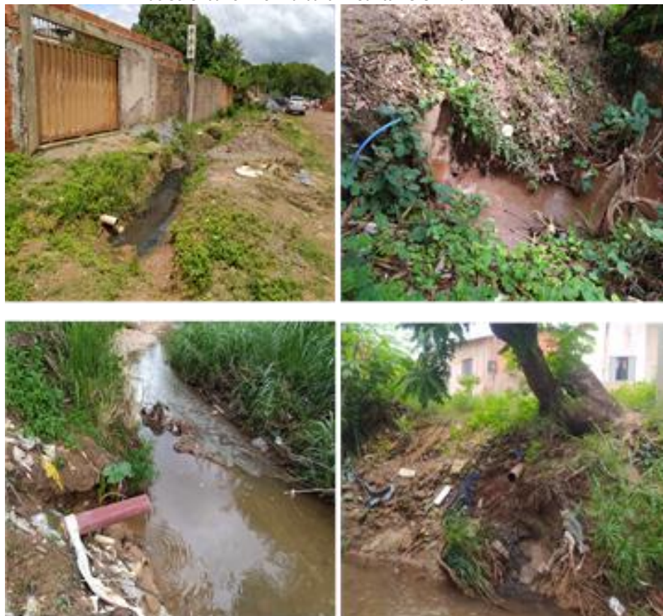
Figura 5 - Desconformidades Ambientais - Descarga de Água Pluvial, Descarga de Esgoto in Natura nos Córregos do Núcleo Urbano Informal Jardim Santa Terezinha.
