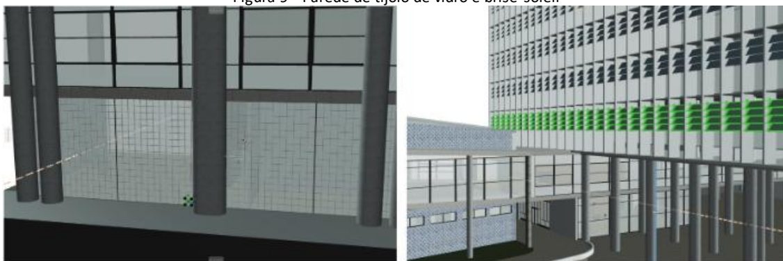
Figura 9 - Parede de tijolo de vidro e brise-soleil
