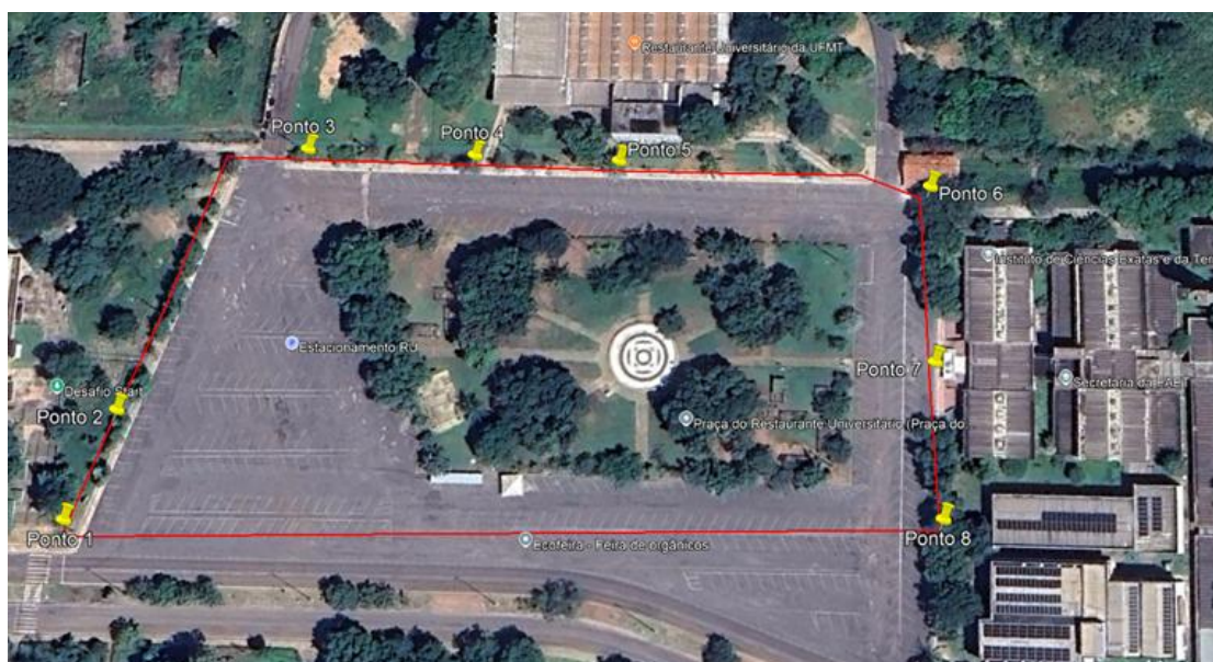
Figura 2 - Localização dos Pontos no entorno da praça do restaurante universitário da UFMT.
