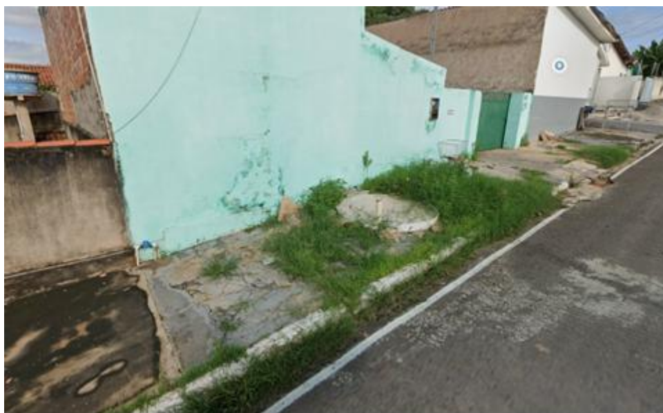
Figura 3 – Localização da fossa séptica construída em local irregular.
